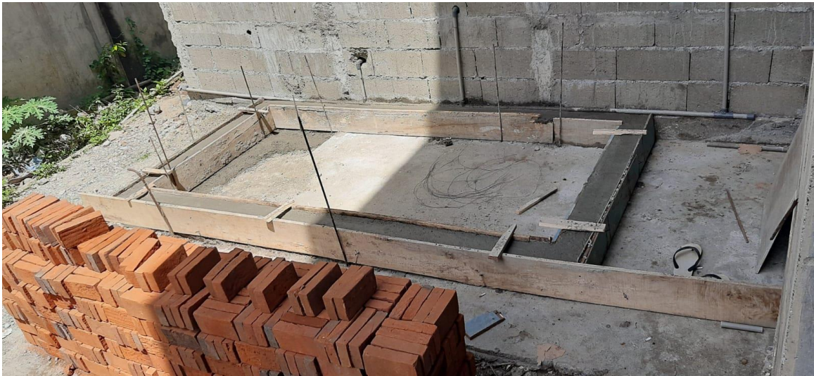
Gambar 6. Pengecoran Sloof
