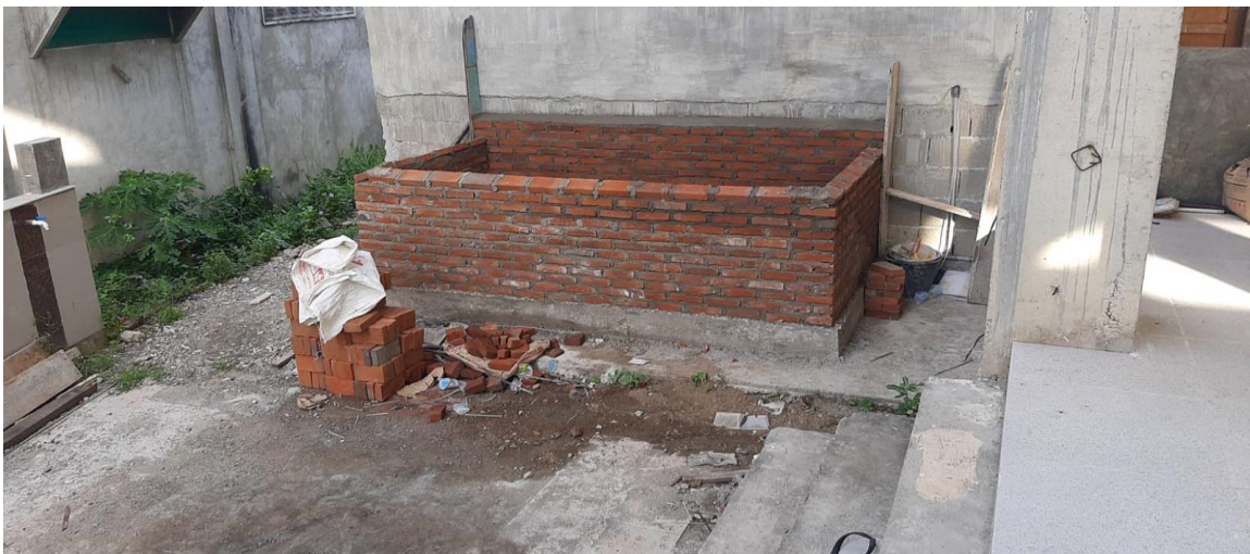
Gambar 7. Pemasangan Batu Bata
